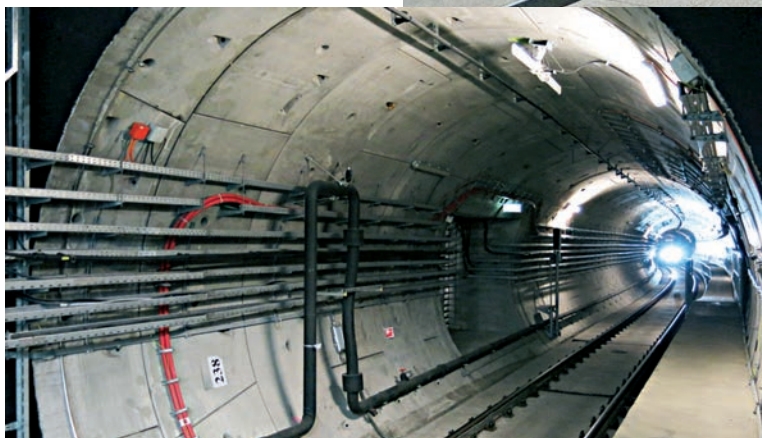
Точната дължина на новата линия е 7,34 км, диаметърът на тунелите ѝ – 5,2 м, ширината на релсите – 1,435 м, а станциите ѝ са на дълбочина от 14,5 м до 31 м
