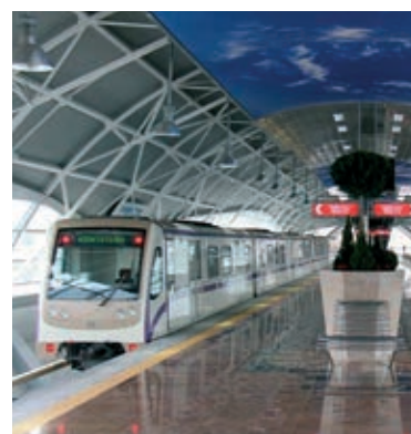
Метростанция „Летище София“
